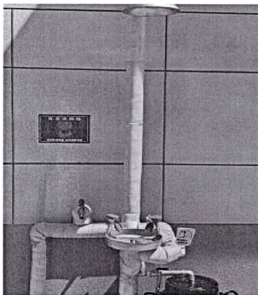
图 15 已在有机浆车间设置喷淋洗眼器
