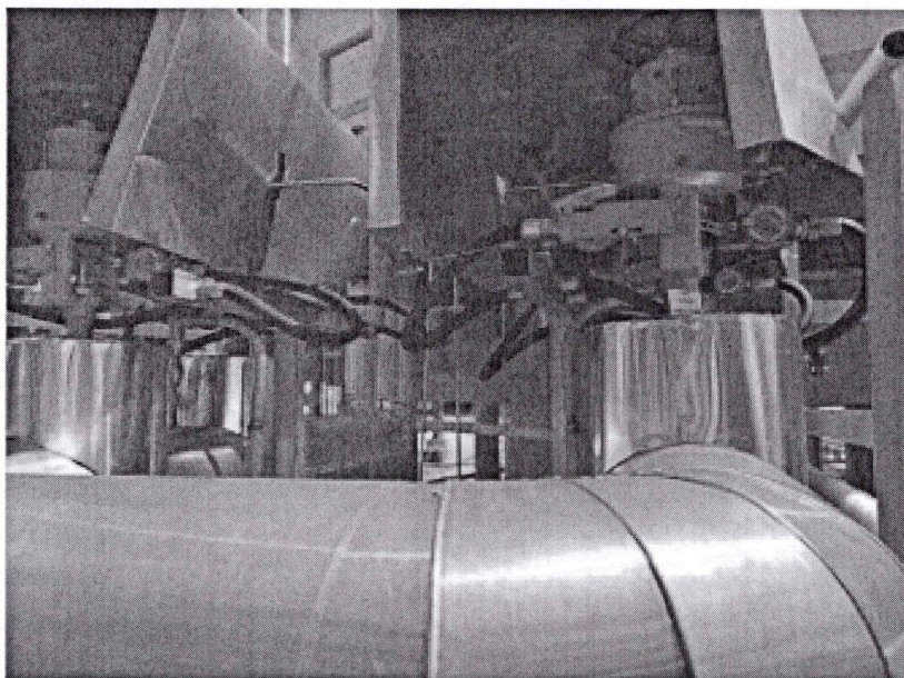
图3 已加厚管道保温
