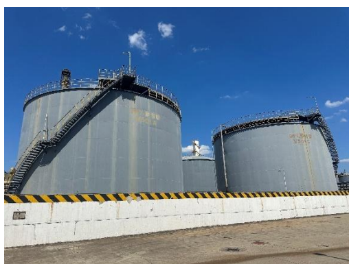
硫酸罐区围堰
